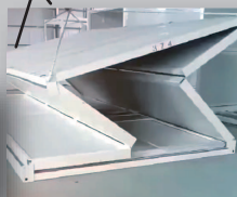
パンタハウスを クレーンで吊上げる
