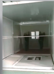
横壁が倒れないよう 組立安全バーの取付
