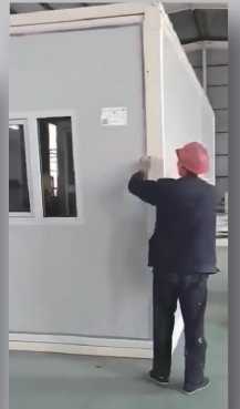
前後の壁を横壁に 固定して完成
