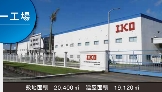
敷地面積 20,400㎡ 建屋面積 19,120㎡
