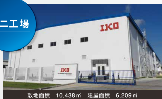
敷地面積 10,438㎡ 建屋面積 6,209㎡
